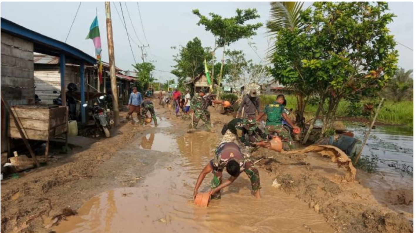
Personel Satgas TMMD Kuras Kubangan Lumpur Demi Percepatan Pengecoran Jalan
