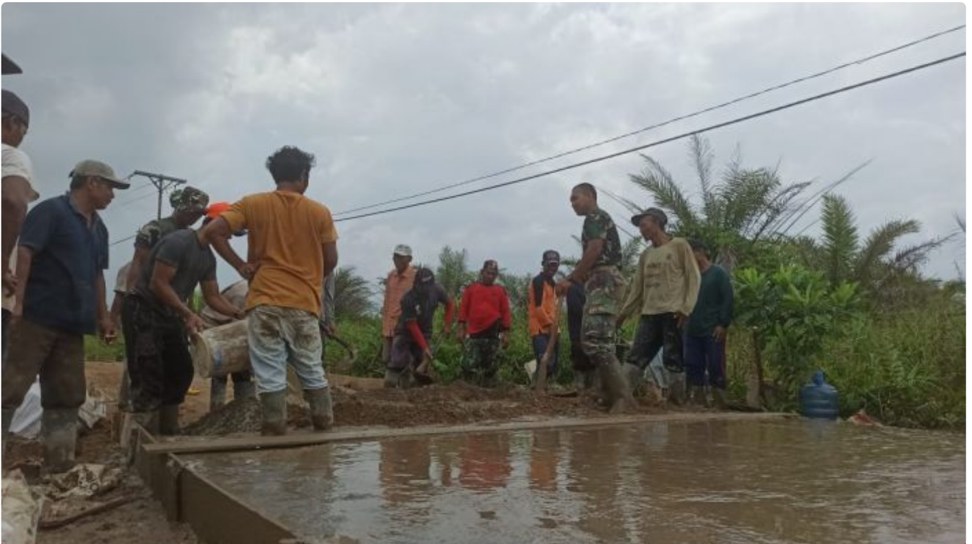
Semangat Warga Trans Lajar Papuyuan Rampungkan Jalan Desa
